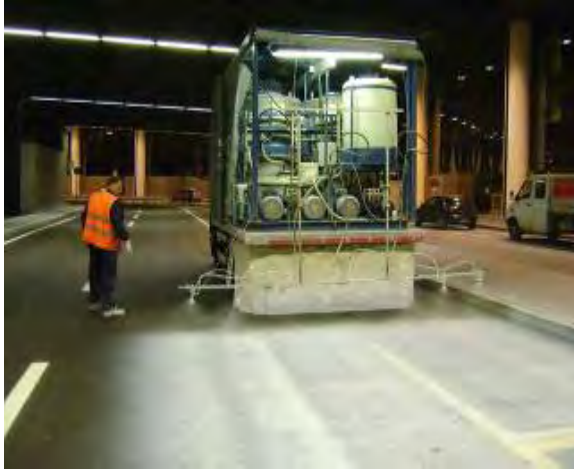
Figura 6. Aplicación de micro-emulsión fotocatalítica, mediante el prototipo patentado por "Impresa Bacchi", en la Terminal 1 del Aeropuerto de Malpensa (Milán).
