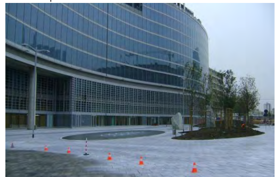
Figura 8. Aplicación de micro-emulsión fotocatalítica en las aceras del Edificio de la Región Lombardía (Milán)
