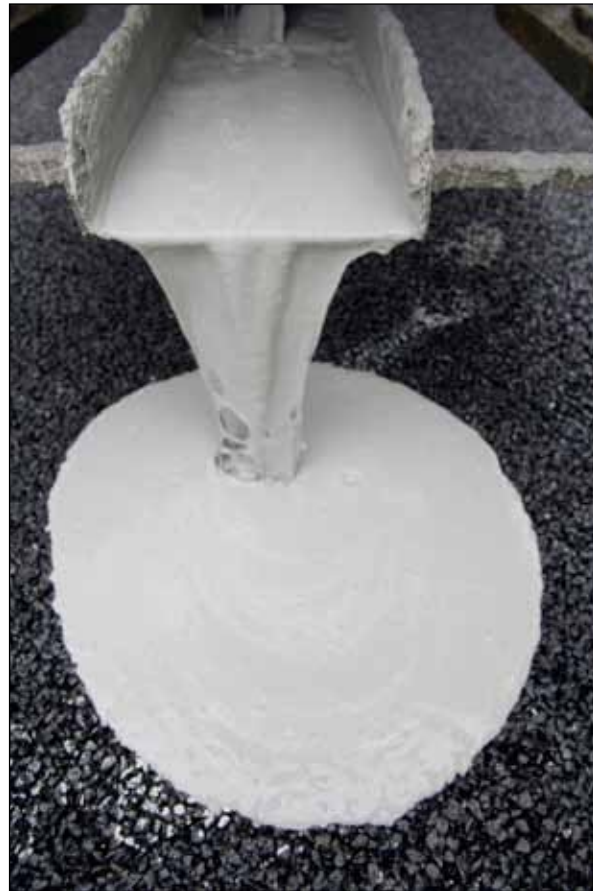
Figura 2. Percolación de lechada especial sobre la capa de mezcla bituminosa drenante.
