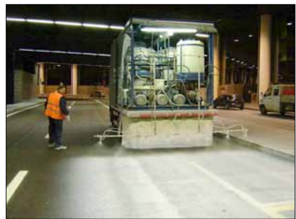
Figura 4. Ejecución de técnica de pulverización sobre rodadura existente.
