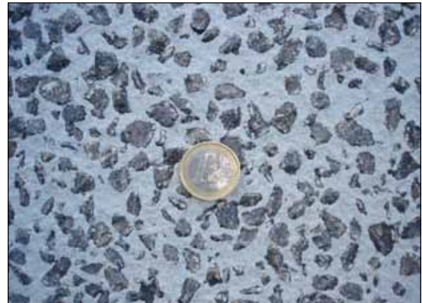
Figura 3. Estado de la superficie de rodadura, tras percolación de la lechada, antes (izda.) y después del granallado (dcha.).
