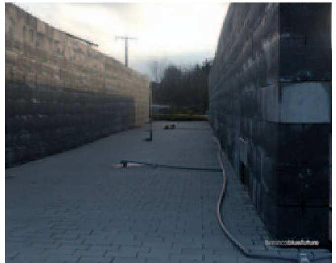
Detalle de canalización de gases de combustión en la prueba de campo.
