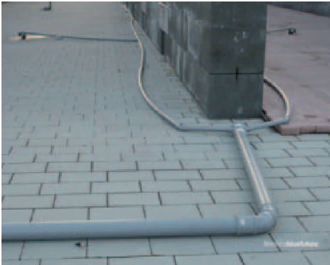
Detalle del cañón con pavimento fotocatalítico de prueba de campo.
