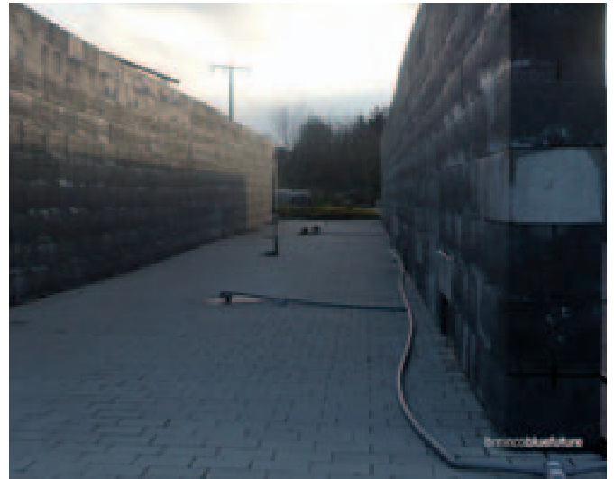
Detalle de canalización de gases de combustión en la prueba de campo.
