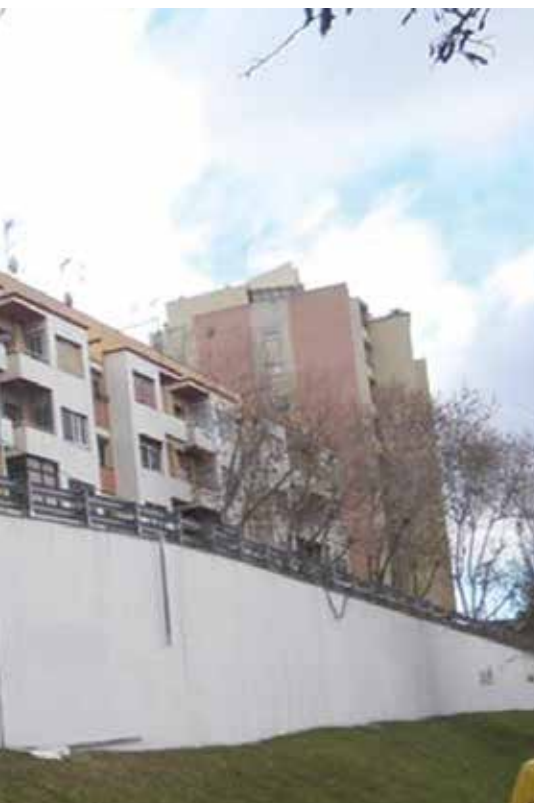
Muro fotocatalítico instalado en el Paseo Fabra i Puig de Barcelona
